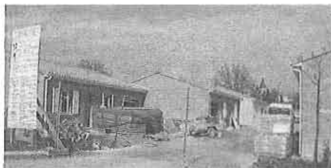
Chantier en cours à la Champagne
